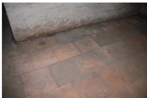
图三 塔坡庙修缮前室内地面
