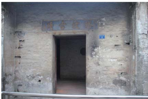
图二 塔坡庙修缮前正面
