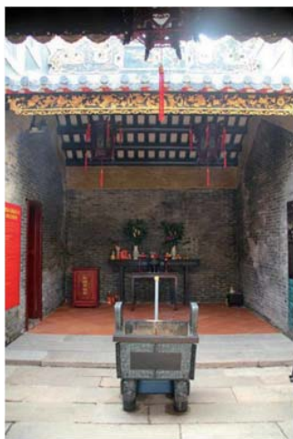
图八 塔坡庙修缮后重现的天井
